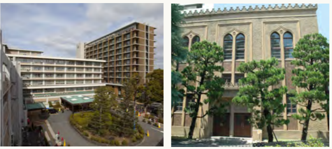
大阪医科大学・附属病院(右の7階建が新館新棟) ヴォーリスが設計した建物。国の有形文化財に指定され、現在は歴史資料館として公開されている。
